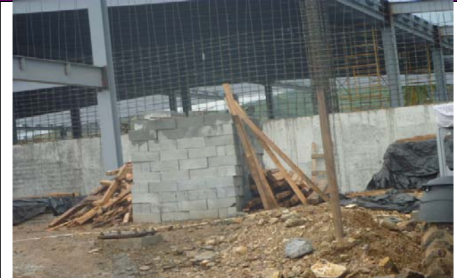
VISTA DEL MURO DE CONCRETO DEL EJE 5, / A YA COLADO Y DESCIMBRADO DE LA PRIMERA ETAPA, SE APRECIA QUE YA ESTA LSTO EL ARMADO, PARA LA
