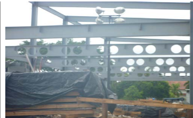
OTRA VISTA DEL EDIFICIO OPERATIVO CO LAS VIGAS EN OS DOS NIVELES
