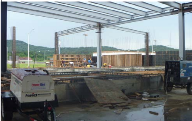
VISTA DEL AVANCE DEL CIMBRADO DE MURO DE EJE 8 / G PREPARANDO PARA EL PRIMER COLADO, Y FONDEADO PARA COLADO DE OSA TAPA DE CIMENTACION CUARTOS
