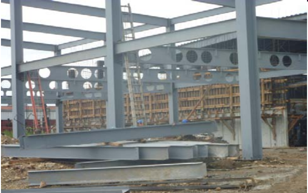
EL EDIFICIO OPERATIV, CON LA ESTRUCTURA PRINCIPAL EN UN AVANCE DEL 90%
