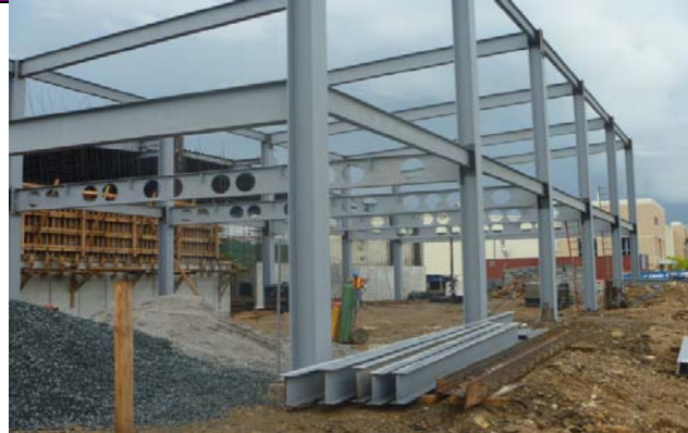
LA ESTRUCTURA YA CUENTA CON PRIMARIO ANTICORROSIVO, PARA PROTEGER EL MATERIAL DE OXIDACION
