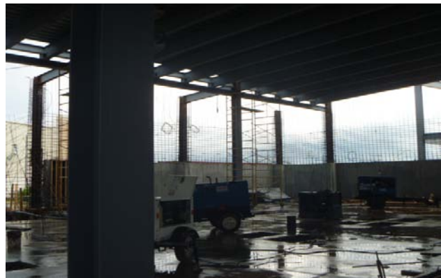
SE APRECIA QUE LA LAMINA CUBIERTA DE LA TECHMBRE ESTA EN UN 80 % DE AVANCE
