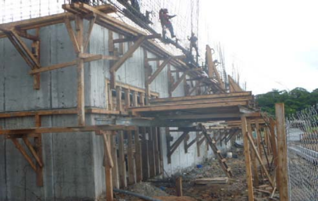
VISTA DEL AVANCE DE ARMADO DE MURO DEL EJE 1 / G PREPARANDOLO PARA EL TRECER TREPADO
