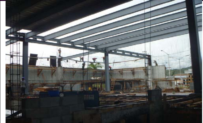
VISTA INTERIOR DEL EDIFICIO DATA CON LAS PLACAS DE CONEXIÓN DE LA ESTRUCTURA METALICA YA EN EL ARMADO
