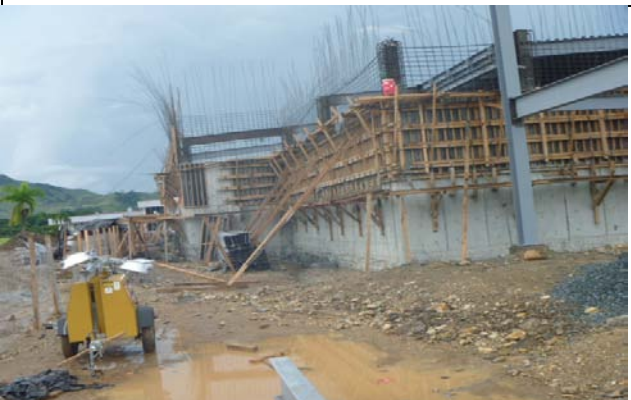
VISTA DE EL AVANCE DE MURO DE CONCRETO DEL EJE 2 / C EL CUAL YA CUENTA CON LA SEGUNDA ETAPA DE COLADO Y YA TIENE EL TRECER NIVEL EN ARMADO
