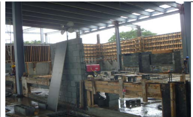
YA SE INICIO LOS TRABAJOS DE ALBAÑILERIA EN LA ZONA DE FASE 1 DE DATA SE ESTAN DEJANDO LAS PREPARACIONES PARA EL AIRE ACONDICIONADO
